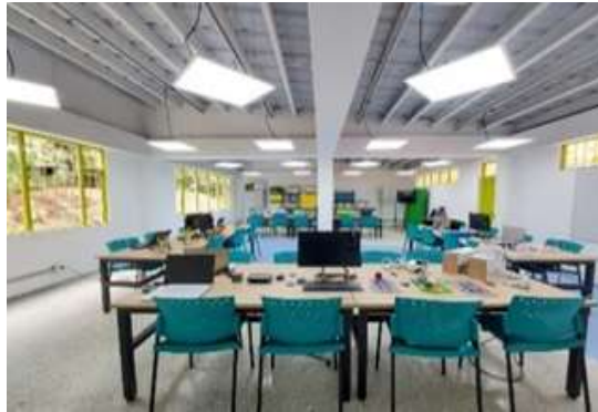
Ilustración 13. Mejoramiento de infraestructura proyecto CEER Sibate
