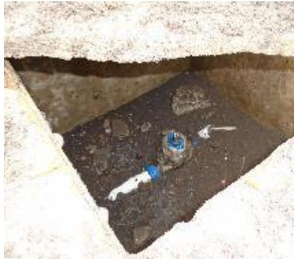
Fotografía 46. Válvula de Corte No 7 para Ramal
