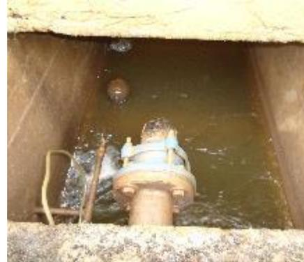
Fotografía 62. Cámara de Perdida de Presión de la C.Q
