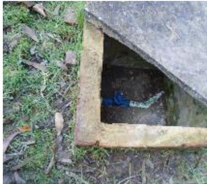
Fotografía 34. Válvula de Corte No 2 para Ramal
