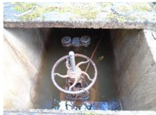
Fotografía 16. Registro de Salida y Válvula de Aire
