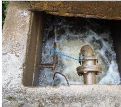
Fotografía 55. Cámara de Perdida de Presión de la C.Q
