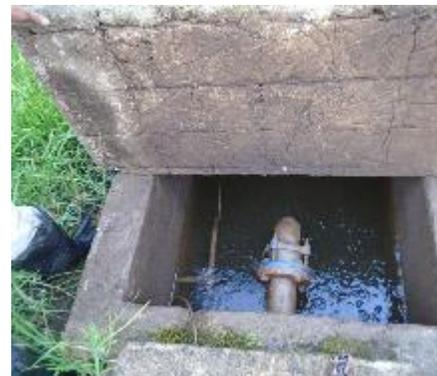
Fotografía 72. Cámara de Perdida de Presión de la C.Q
