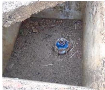
Fotografía 37. Válvula de Corte No 3
