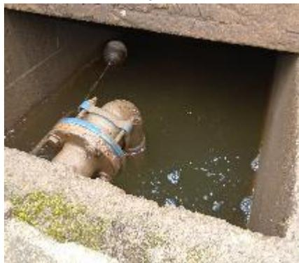
Fotografía 71. Cámara de Perdida de Presión de la C.Q
