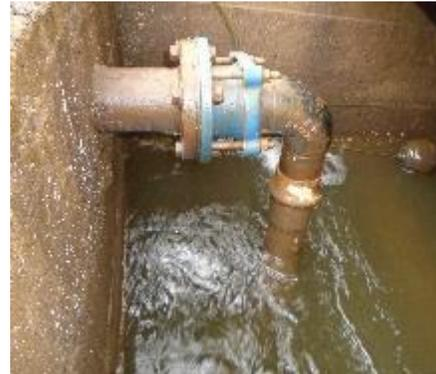
Fotografía 64. Cámara de Perdida de Presión de la C.Q
