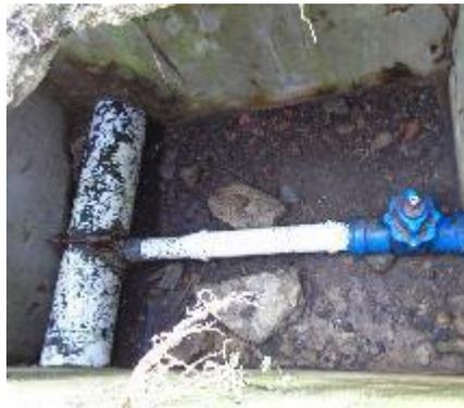
Fotografía 42. Válvula de Corte No 5 para Ramal
