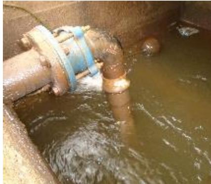
Fotografía 63. Cámara de Perdida de Presión de la C.Q
