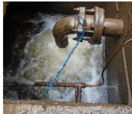
Fotografía 54. Cámara de Perdida de Presión de la C.Q
