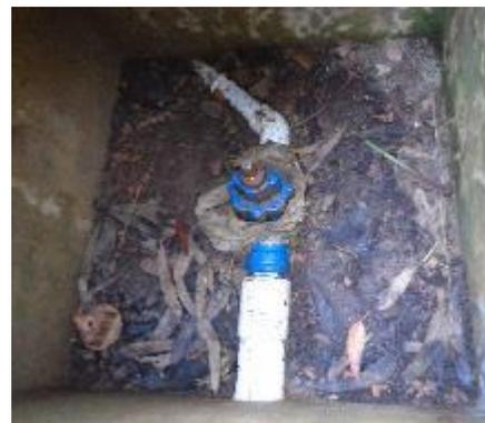
Fotografía 31. Válvula de Corte No 1 para Ramal
