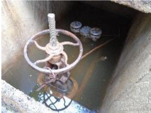
Fotografía 17. Registro de Salida y Válvula de Aire
