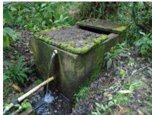
Fotografía 8. Desarenador (Salida)
