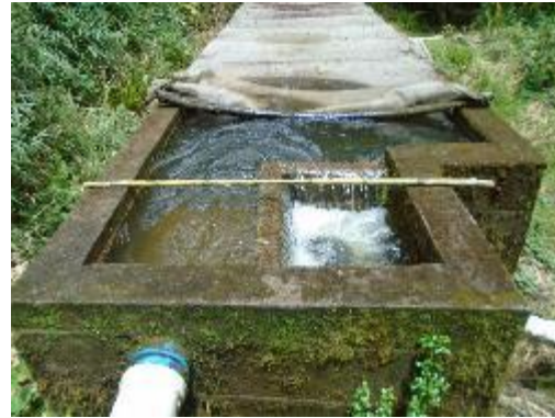
Fotografía 12. Vista Interna del Desarenador - Ingreso
