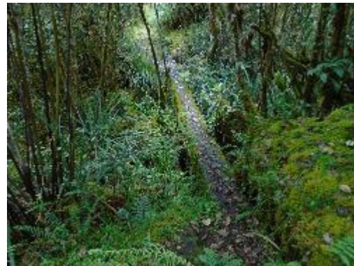
Fotografía 34. Paso elevado 2, encofrado, después de la ventosa 3
