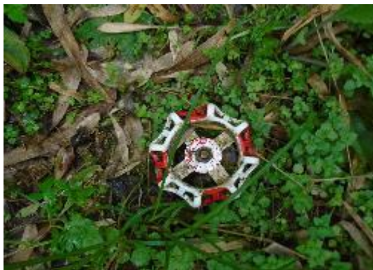
Fotografía 21. Vista Válvula de Purga
