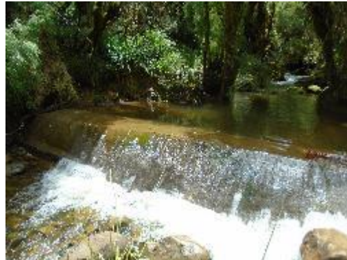
Fotografía 4. Vista frontal del Dique
