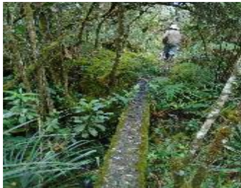
Fotografía 33. Paso elevado 2, encofrado, después de la ventosa 3
