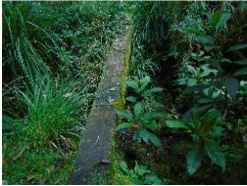
Fotografía 31. Paso elevado 1, Encofrado
