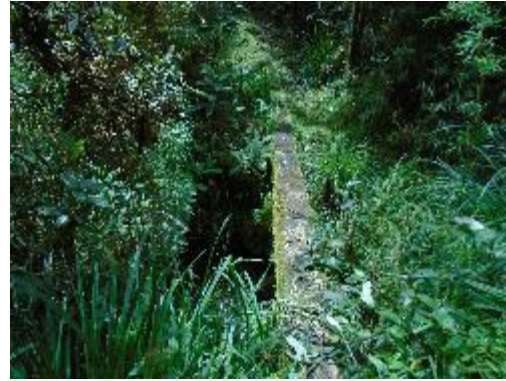
Fotografía 32. Paso elevado 1, Encofrado
