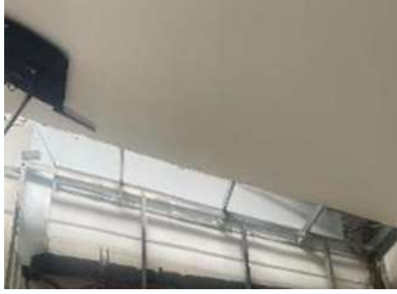
Demolición Cielo Raso Falso
