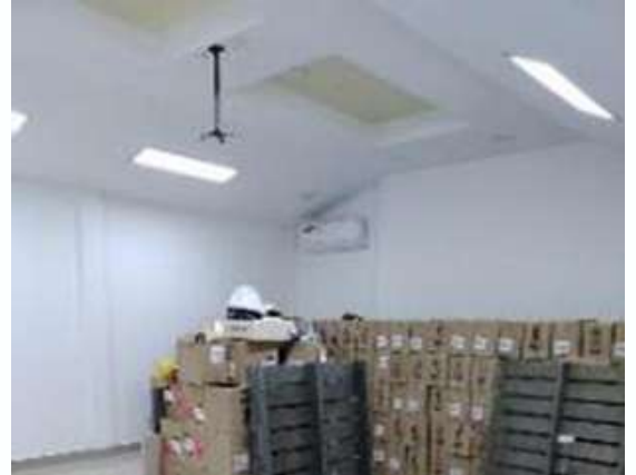
Cielo Raso Plano Drywall
