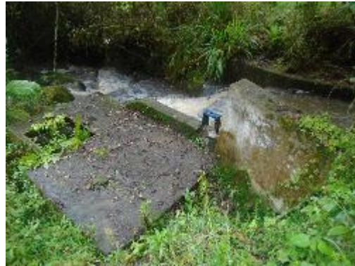
Fotografía 8. Vista Frontal de Bocatoma
