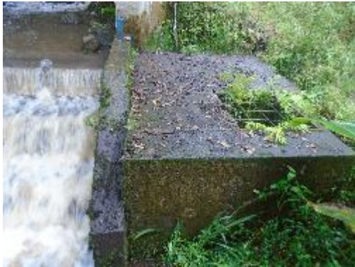
Fotografía 7. Vista Frontal de Bocatoma
