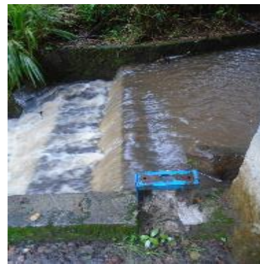
Fotografía 2. Vista Frontal de Bocatoma
