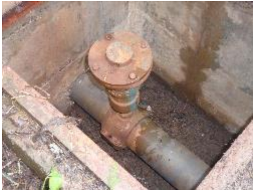
Fotografía 27. Válvula de ventosa
