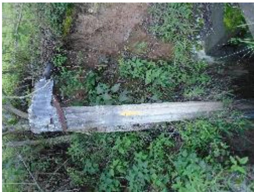
Fotografía 23. Conducción (Después de la Cámara de quiebre 5), por debajo de la vía
