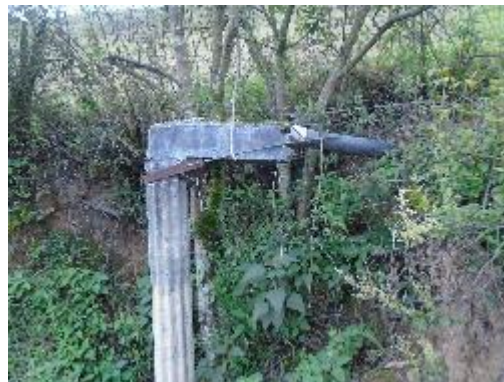
Fotografía 24. Conducción (Después de la Cámara de quiebre 5), por debajo de la vía
