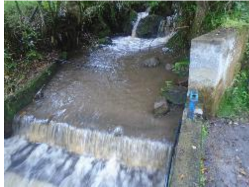
Fotografía 6. Vista Frontal de Bocatoma
