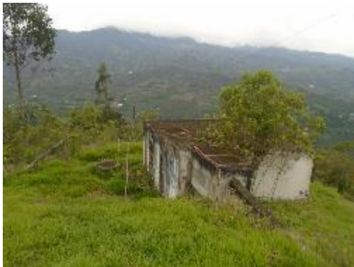
Fotografía 39. Vista Lateral, Cámara de quiebre 5
