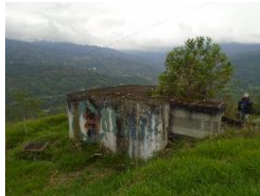
Fotografía 40. Vista Lateral, Cámara de quiebre 5
