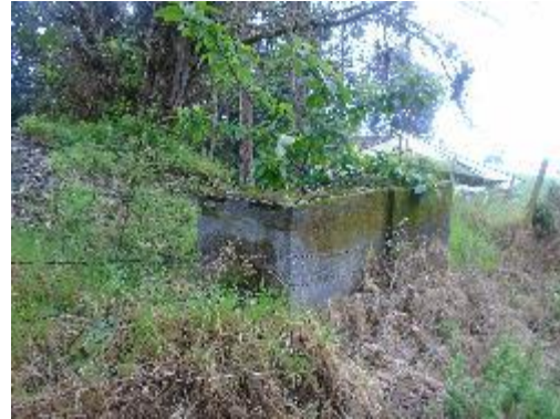
Fotografía 32. Vista Lateral, Cámara de quiebre 1
