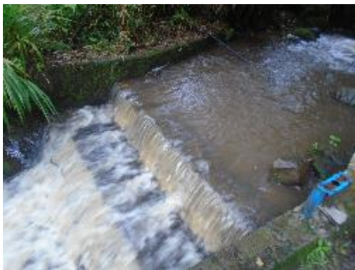
Fotografía 1. Vista Frontal de Bocatoma
