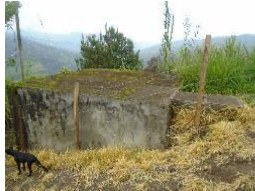
Fotografía 38. Vista Lateral, Cámara de quiebre 4
