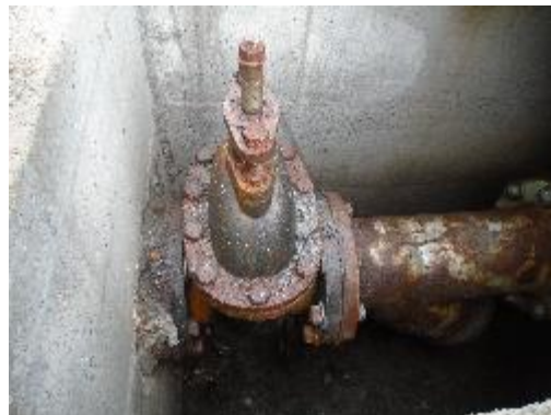
Fotografía 30. Válvula de corte, Cámara de quiebre 1
