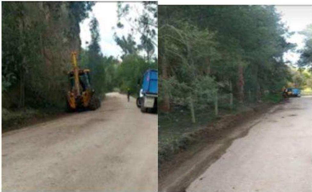
Registro fotográfico recuperación de Cunetas
