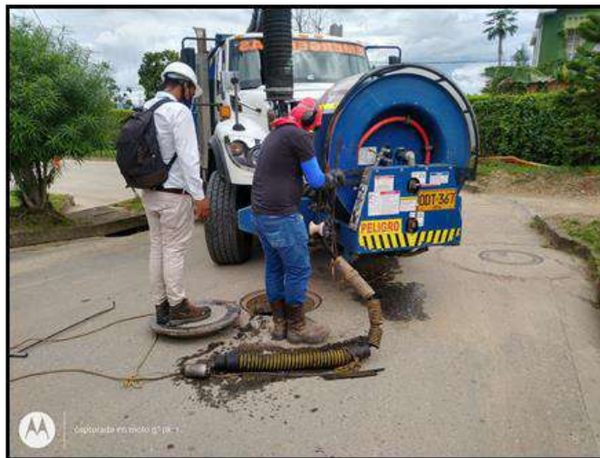
Atención con equipo de succión presión en el municipio del Colegio
