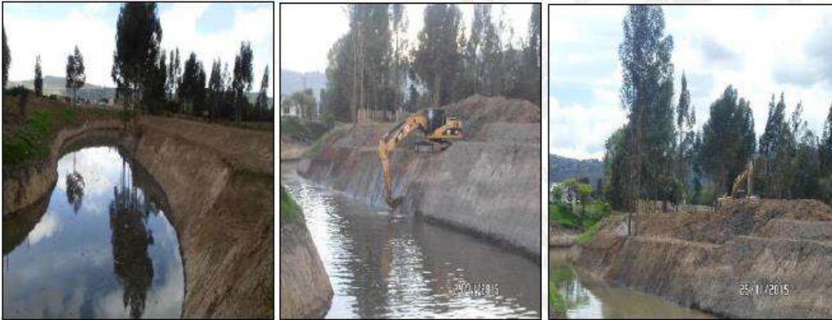
PERFILADO DE TALUDES EXTRACCIÓN Y CONFORMACIÓN DEL MATERIAL, ANTES Y DESPUÉS DE LA INTERVENCIÓN
