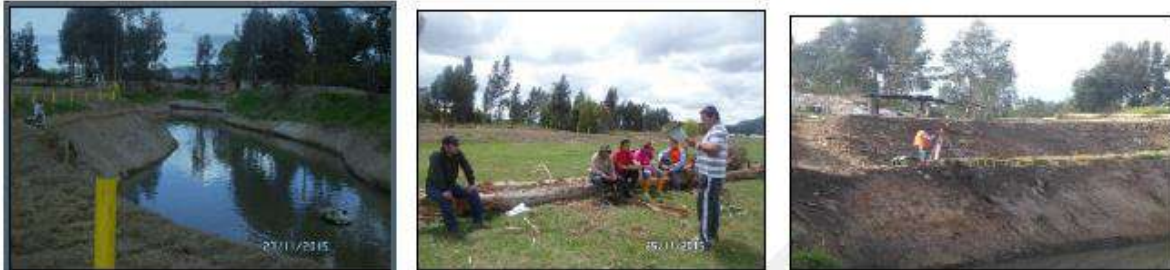
CONTROL TOPOGRÁFICO Y CHARLA DE SEGURIDAD Y SALUD EN EL TRABAJO
