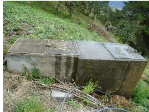
Fotografía 53. Vista Lateral, Cámara de quiebre 2
