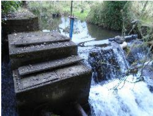
Fotografía 7. Vista Frontal de Bocatoma
