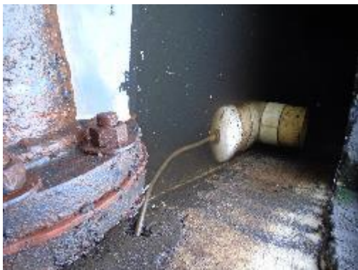
Fotografía 60. Interior, caja húmeda, tanque
