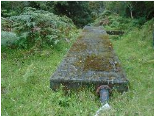
Fotografía 21. Vista Superior Desarenador entrada
