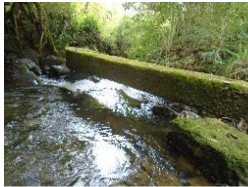
Fotografía 14. Aducción Encofrada
