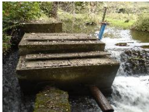
Fotografía 6. Vista Frontal de Bocatoma
