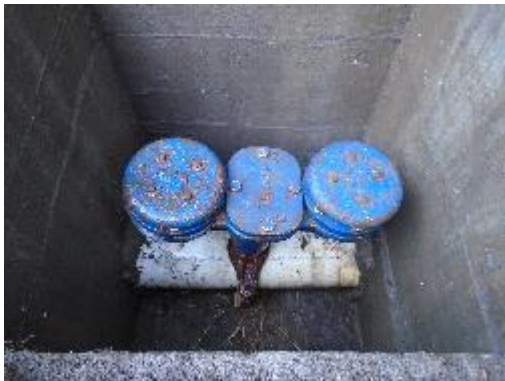
Fotografía 38. Vista Superior, Válvula Ventosa 3 (después de la Cámara de quiebre 1)
