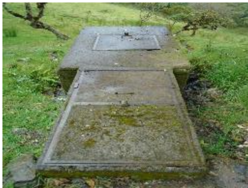
Fotografía 44. Vista Superior, Cámara de quiebre 1
