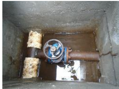
Fotografía 41. Vista Superior, Válvula de purga 1 (después de la Cámara de quiebre 1)
