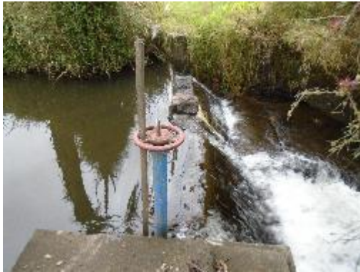
Fotografía 1. Vista Frontal de Bocatoma
