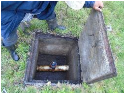
Fotografía 32. Vista Interna, Válvula Ventosa (después del desarenador)
