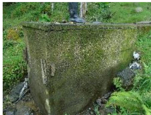
Fotografía 43. Vista Lateral, Cámara de quiebre 1
