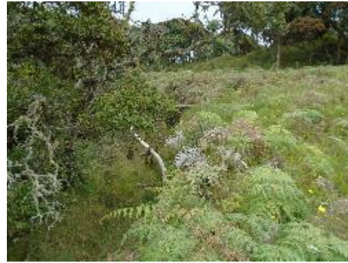
Fotografía 18. Aducción problema de estabilidad
