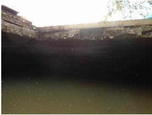
Fotografía 62. Interior, caja húmeda, tanque
