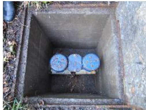
Fotografía 39. Vista Superior, Válvula Ventosa 3 (después de la Cámara de quiebre 1)
