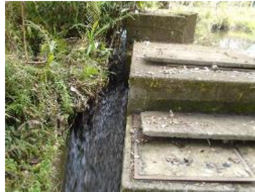
Fotografía 8. Canal de agua a un costado de la estructura.
