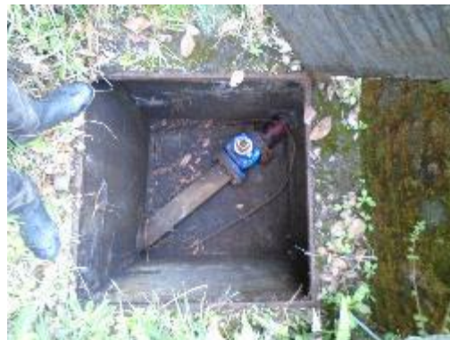
Fotografía 24. Vista válvula de lavado
