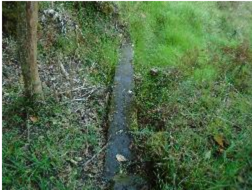
Fotografía 30. Encofrado Conducción (después de la ventosa 3)
