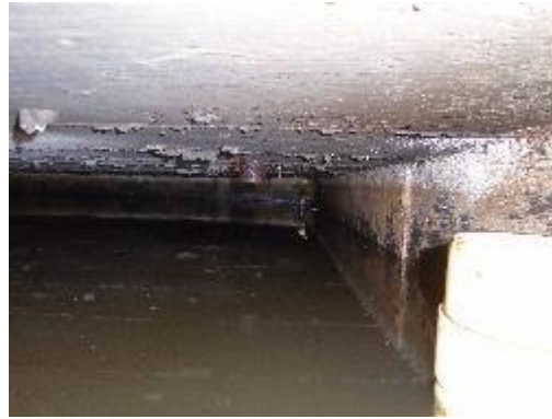
Fotografía 63. Interior, caja húmeda ,tanque
