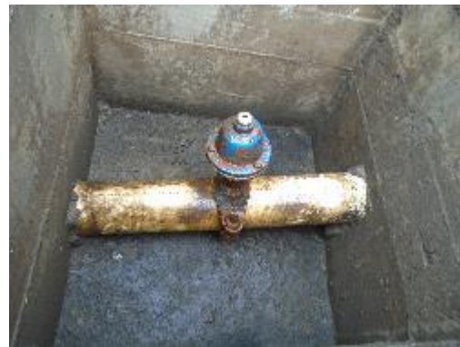
Fotografía 33. Vista Interna, Válvula Ventosa (después del desarenador)
