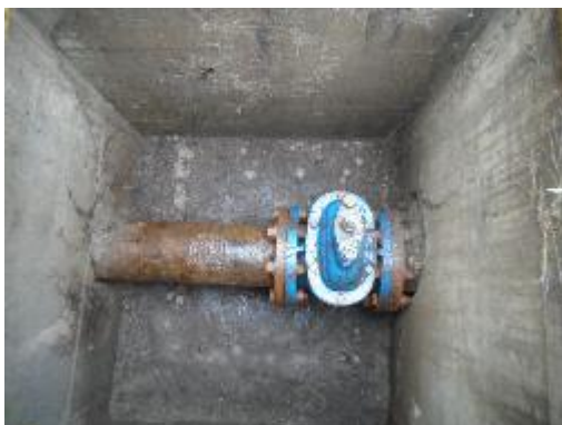
Fotografía 25. Vista válvula de salida
