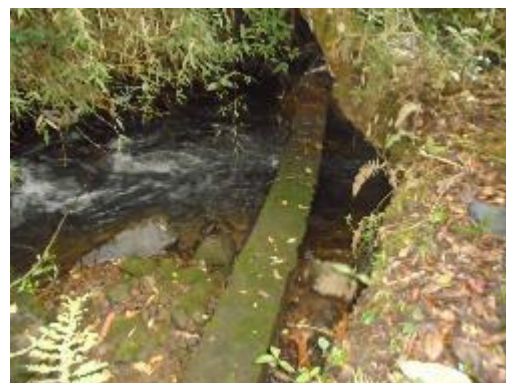
Fotografía 10. Aducción Encofrada
