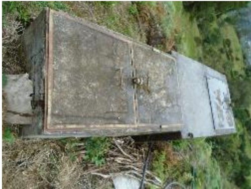
Fotografía 52. Vista Externa, Cámara de quiebre 2
