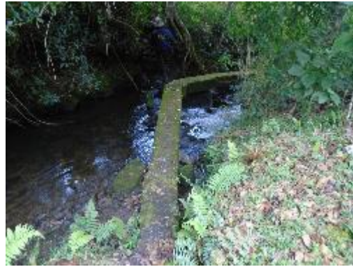
Fotografía 12. Aducción Encofrada
