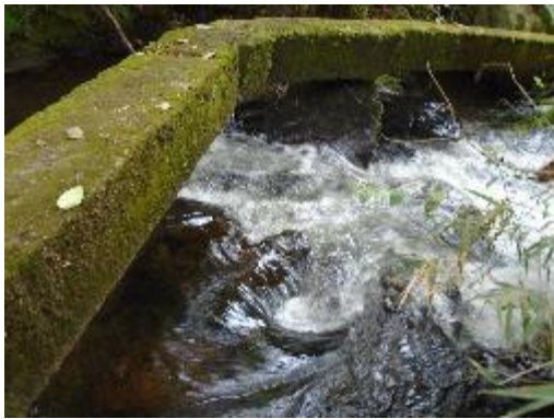
Fotografía 13. Aducción Encofrada
