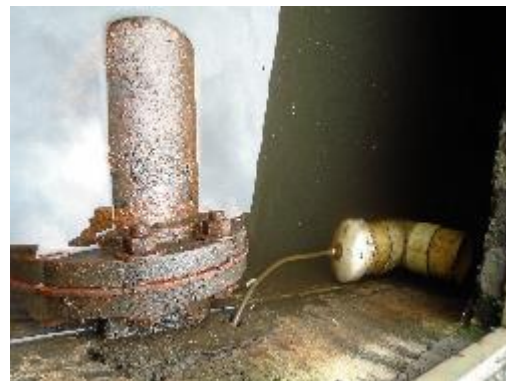
Fotografía 61. Interior, caja húmeda, tanque
