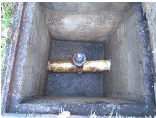
Fotografía 32. Vista Interna, Válvula Ventosa (después del desarenador)
