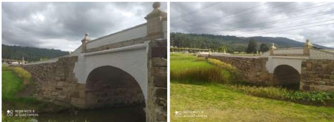
REGISTRO FOTOGRÁFICO FINAL
