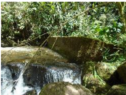
Fotografía 5. Vista Lateral de Bocatoma
