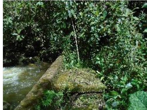
Fotografía 2. Vista Posterior de Bocatoma
