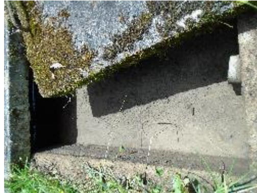
Fotografía 15. Vista superior ingreso desarenador
