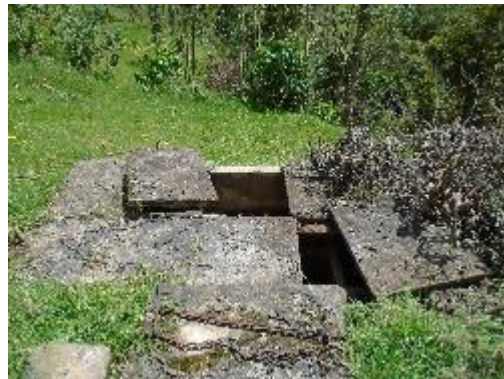
Fotografía 17. Vista lateral de desarenador
