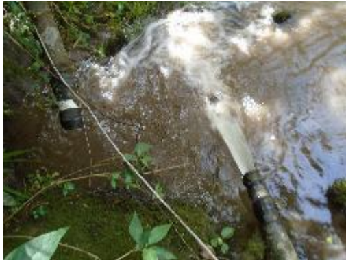
Fotografía 10. Desconexión de manguera
