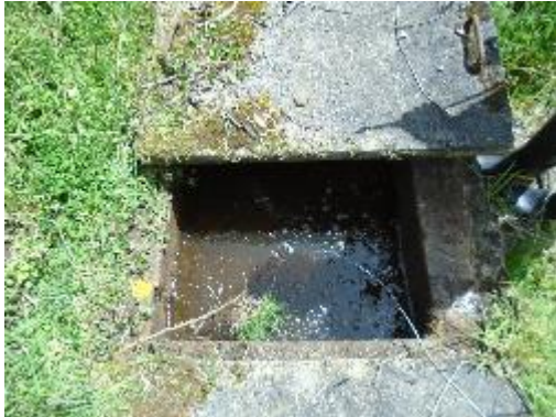
Fotografía 14. Vista superior ingreso desarenador
