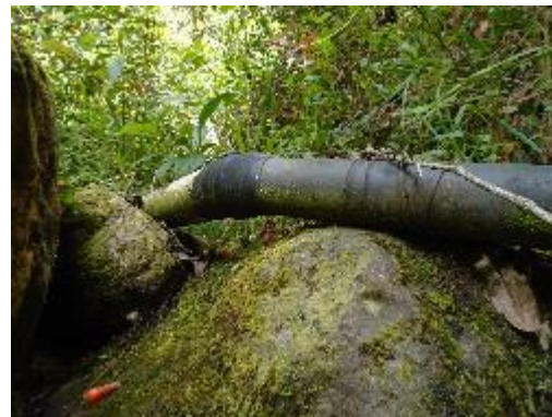
Fotografía 9. Manguera de Aducción- reparaciones
