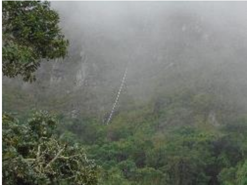
Fotografía 36. Vista frontal de anclaje al cerro
