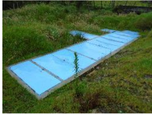
Fotografía 14. Vista lateral desarenador 1
