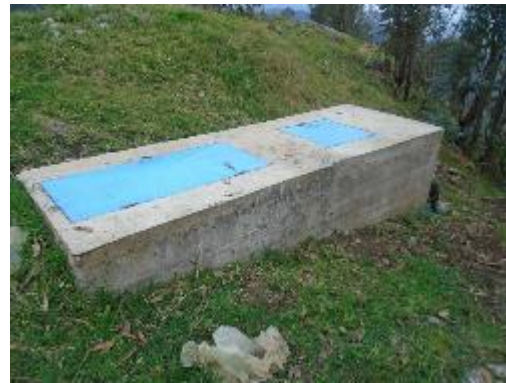
Fotografía 44. Vista Lateral, Cámara de quiebre 1
