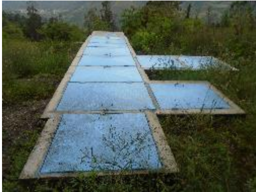
Fotografía 19. Vista Frontal Desarenador 2
