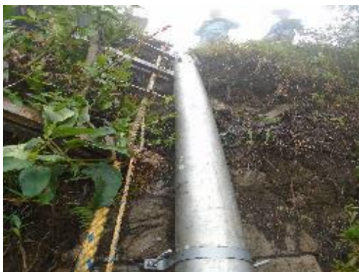
Fotografía 34. Anclaje a la roca
