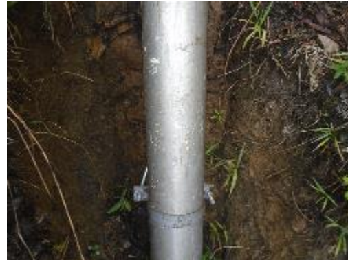
Fotografía 33. Anclaje a la roca
