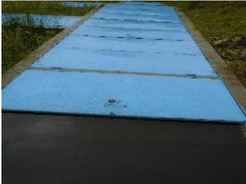
Fotografía 13. Vista Frontal Desarenador 1
