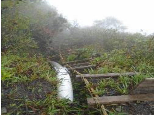
Fotografía 30. Inicio de anclaje
