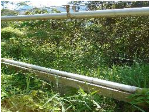
Fotografía 51. Tubería instalada por viga y paso elevado
