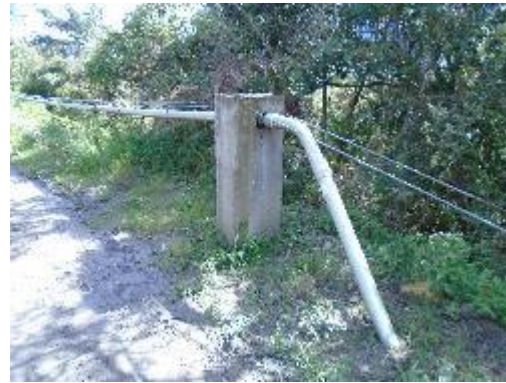
Fotografía 48. Pasos elevados- Soportes
