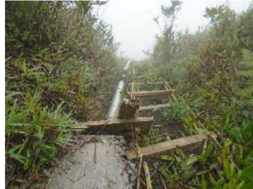
Fotografía 31. Anclaje y encofrado
