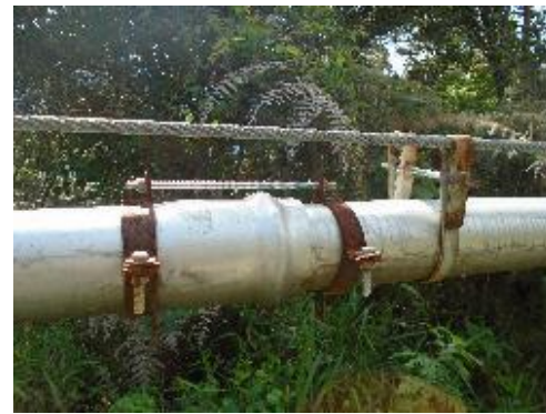
Fotografía 50. Anclaje campana espigo
