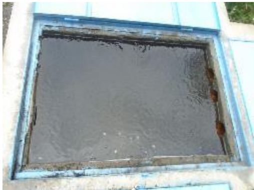
Fotografía 15. Zona de entrada desarenador 2
