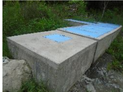
Fotografía 20. Vista lateral Desarenador 2
