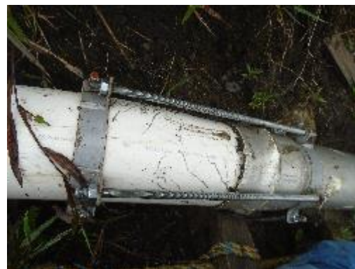
Fotografía 35. Anclaje campana espigo
