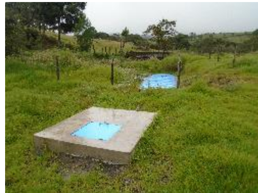
Fotografía 22. Caja del sistema de macro medición
