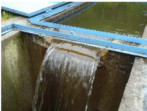
Fotografía 11. Excesos Desarenador 1
