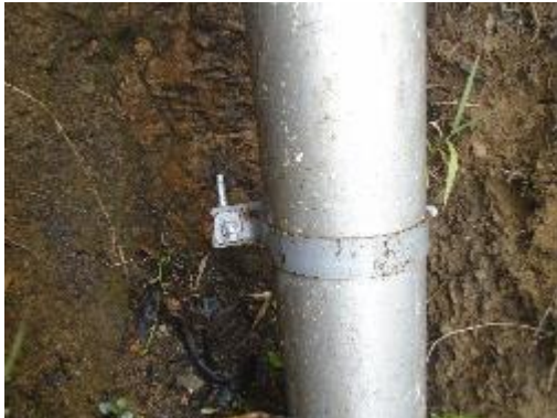
Fotografía 32. Anclaje a la roca
