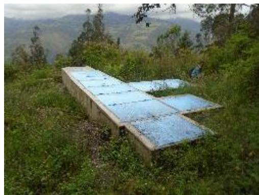
Fotografía 18. Vista lateral Desarenador 2
