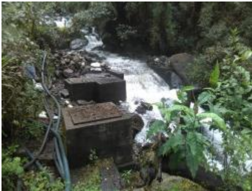
Fotografía 1. Vista Frontal de Bocatoma
