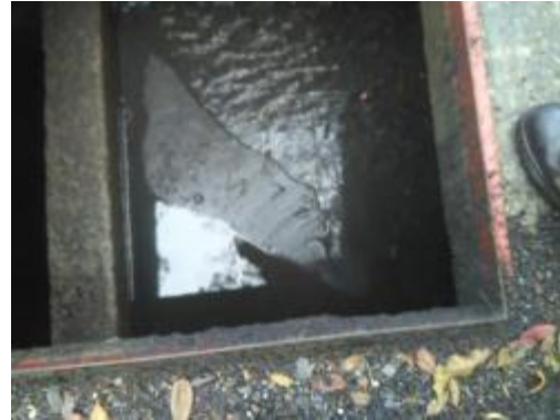
Fotografía 6. Vista Zona de aquietamiento
